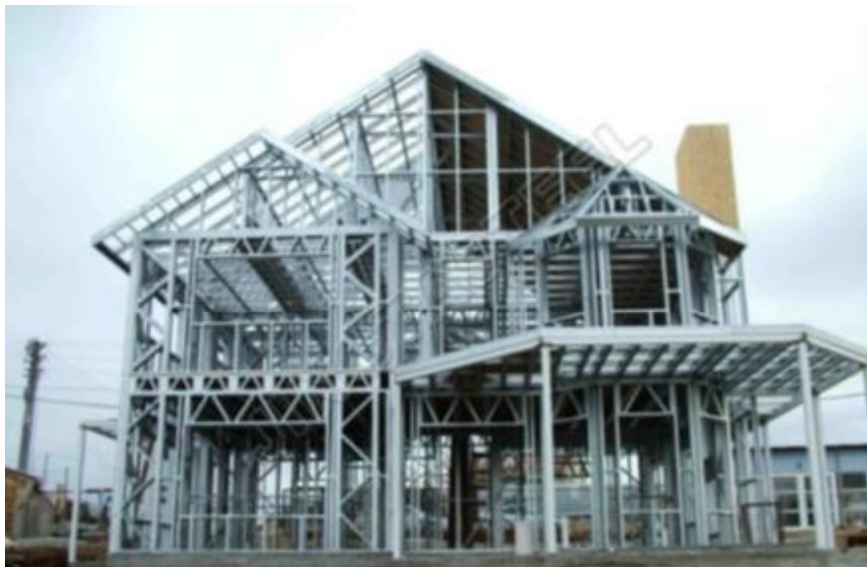
Figura 2 - Estrutura em LSF
